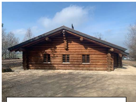
Traitement et peinture terminés
