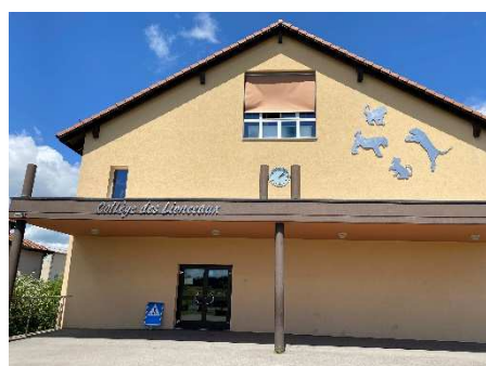
Une paroi et une fenêtre sud
