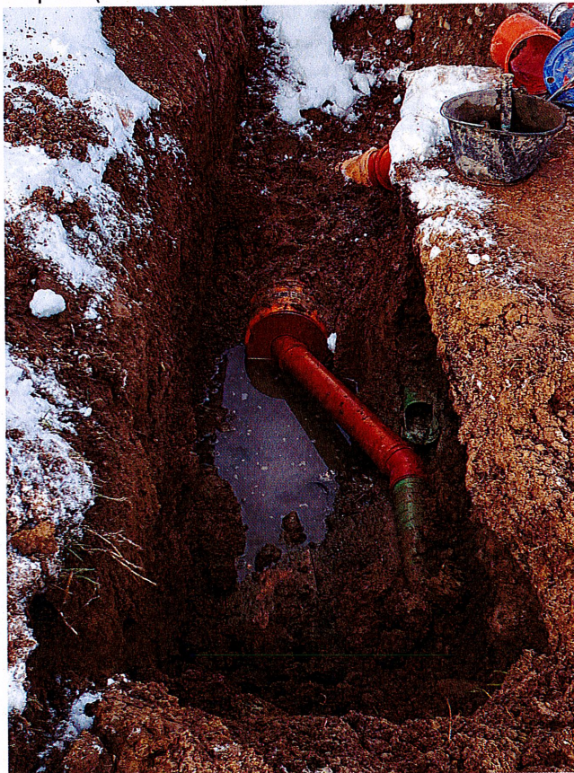
Tuyau de drainage percé de 100 mm (vert en PVC) raccordé sur nouveau collecteur de 300 mm (PP=polypropylène)
